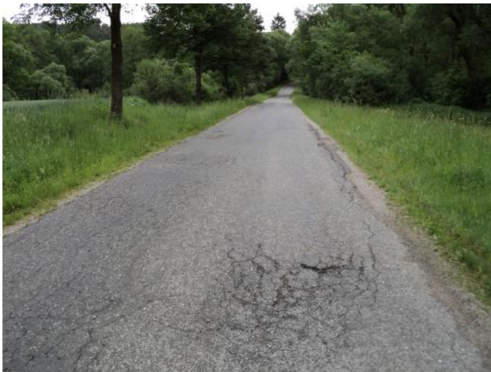
Síťové trhliny, plošná deformace vozovky – km 2,950.
