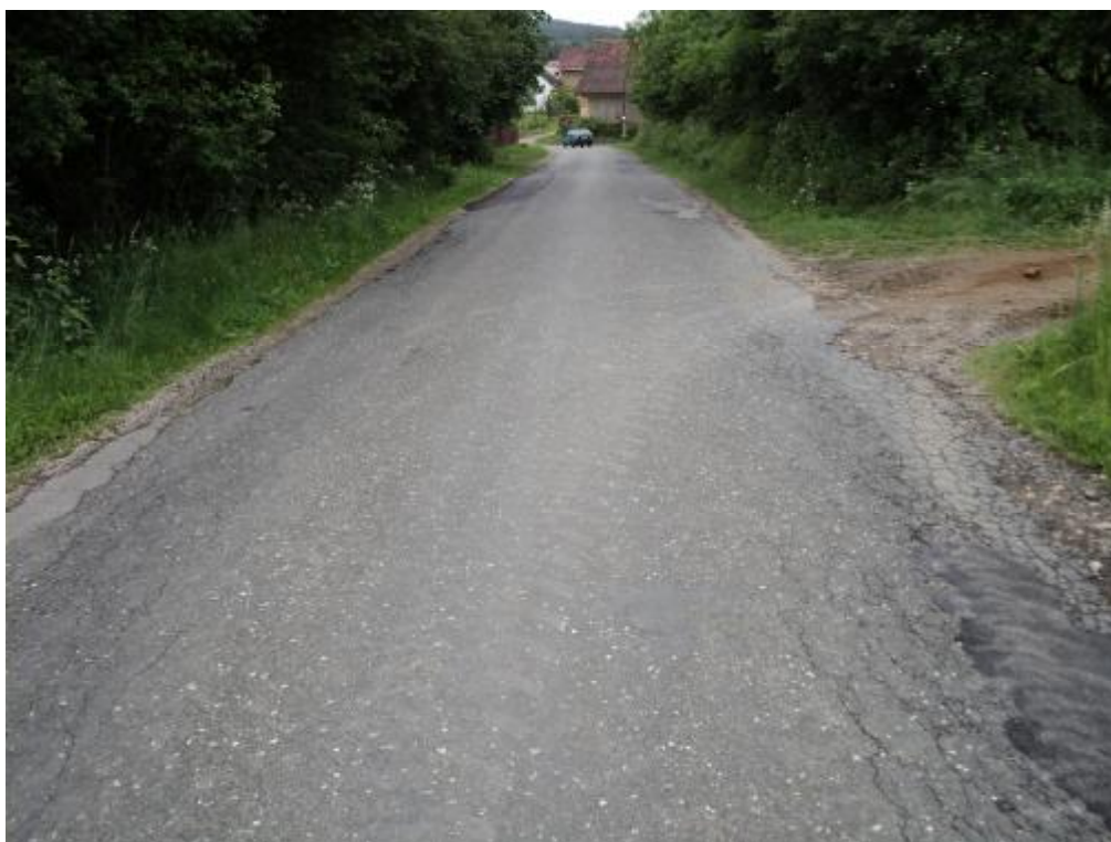
Síťové trhliny, odlamování okrajů vozovky – km 0,850.
