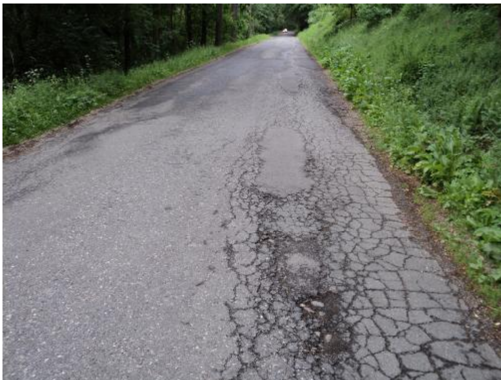
Síťové trhliny, výtluky v krytu – km 0,170.
