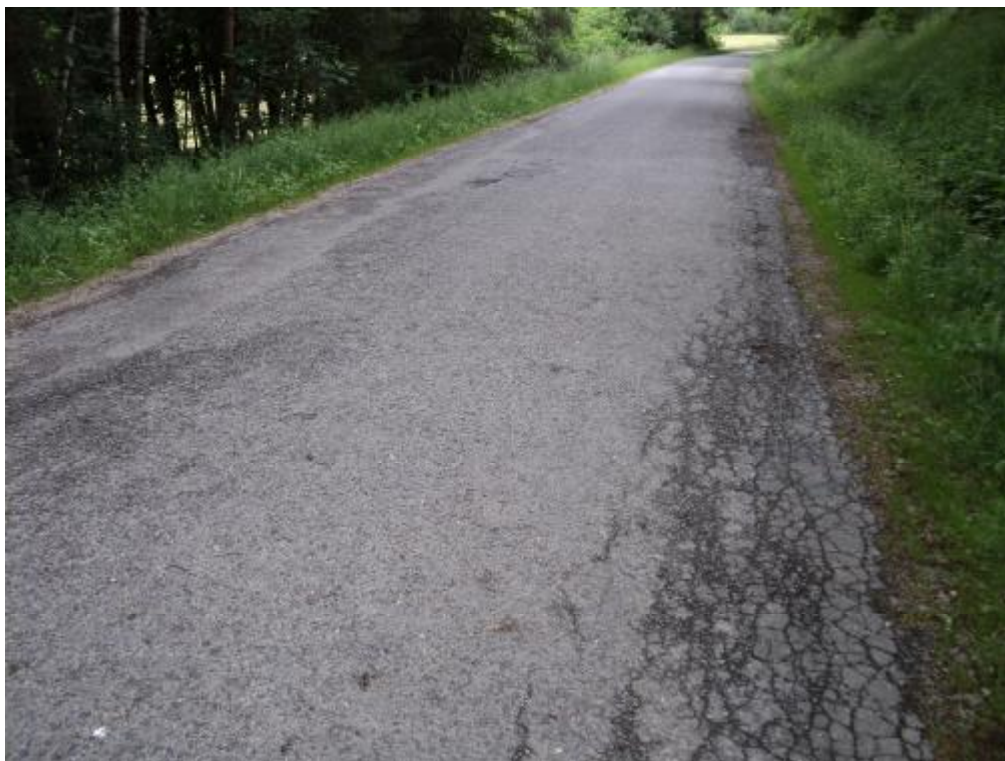
Síťové trhliny, odlamování okrajů vozovky – km 1,550.
